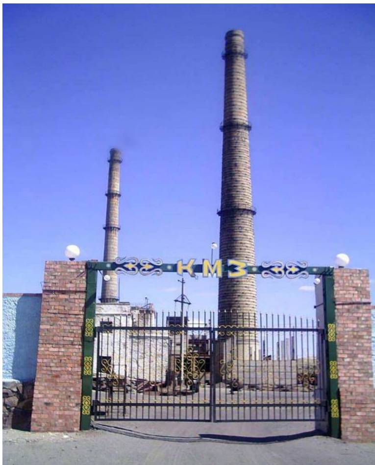
Карсакабайский металлургический завод.
